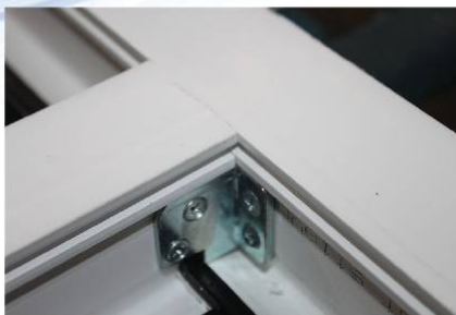
اتصال صحیح و بدون عیب پروفیل میانی
