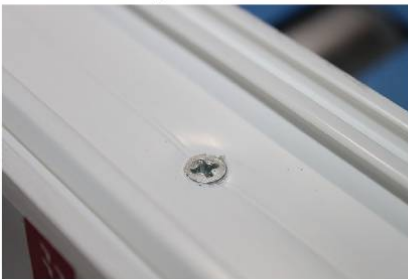
هم سطحی پیچ با سطح پروفیل و موقعیت عرضی آن
