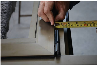
کنترل فاصله نصب لولای قابل تنظیم
