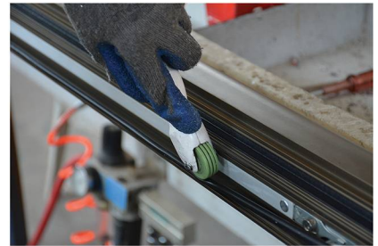
نصب لاستیک آبدی
